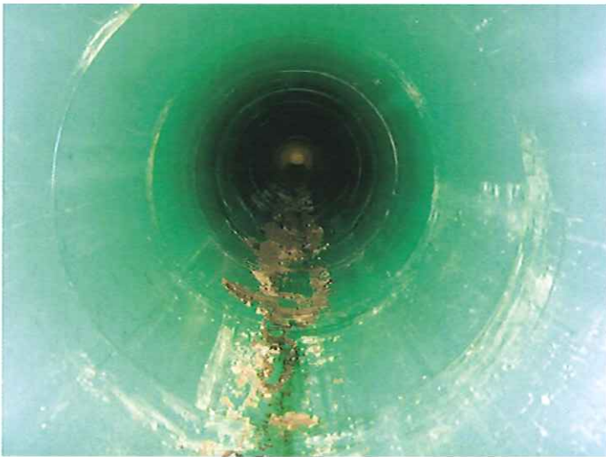
Blick in die vorgetriebene n Produktrohre aus PP-HM, System Schöngen
