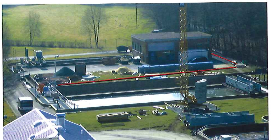
Kläranlage Heinzeberg, rot markiert die Vortriebsstrecken.
