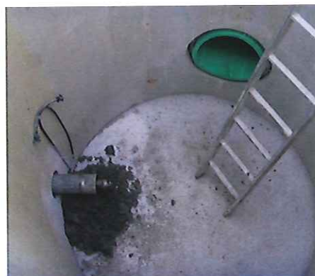
Ankunft der Pilotbohrung im Zielschacht.
