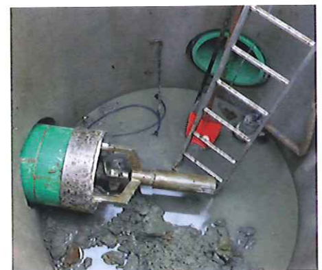
Ankunft Kombibohrkopf im Zielschacht.
